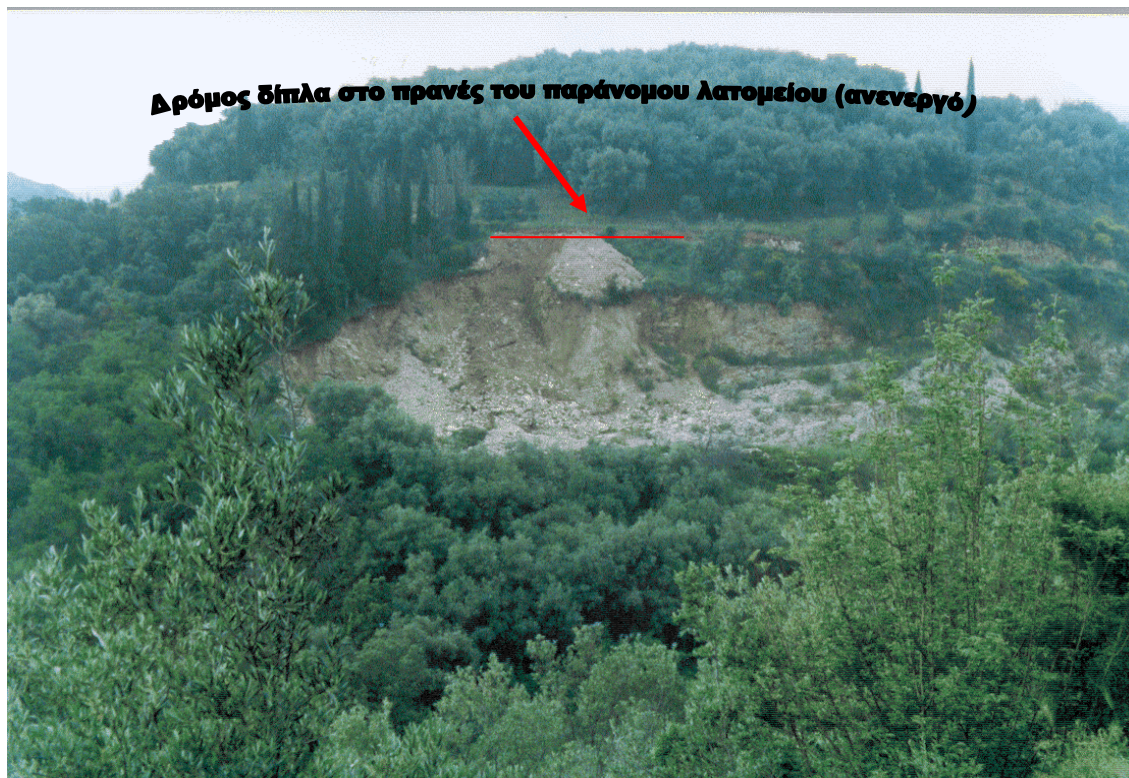
φωτ. 1. Άποψη του δρόμου και του πρανούς
