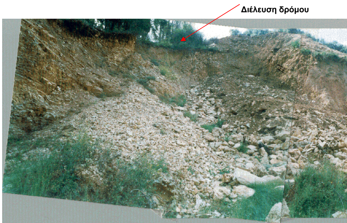
φωτ. 2. Πρανές κατάντη του δρόμου
